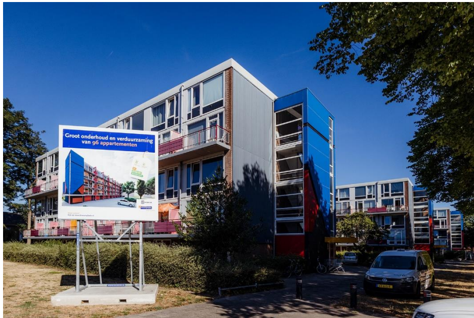
Figuur 3: Project Fazantstraat
