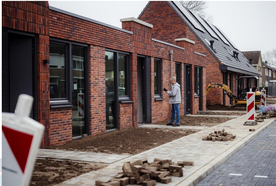
Figuur 2: Project Ludgerstraat
