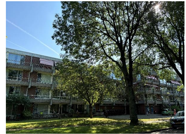
Figuur 1.2 Seniorencomplex aan de Willem de Zwijgerlaan
