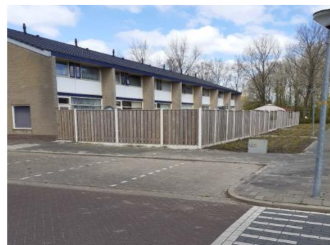
Foto 5: Gerealiseerde achteruitgangen en schuttingen aan de Zijperlaan
