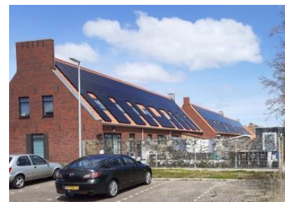
Foto 3: Project sloop/nieuwbouw Smidsweg
