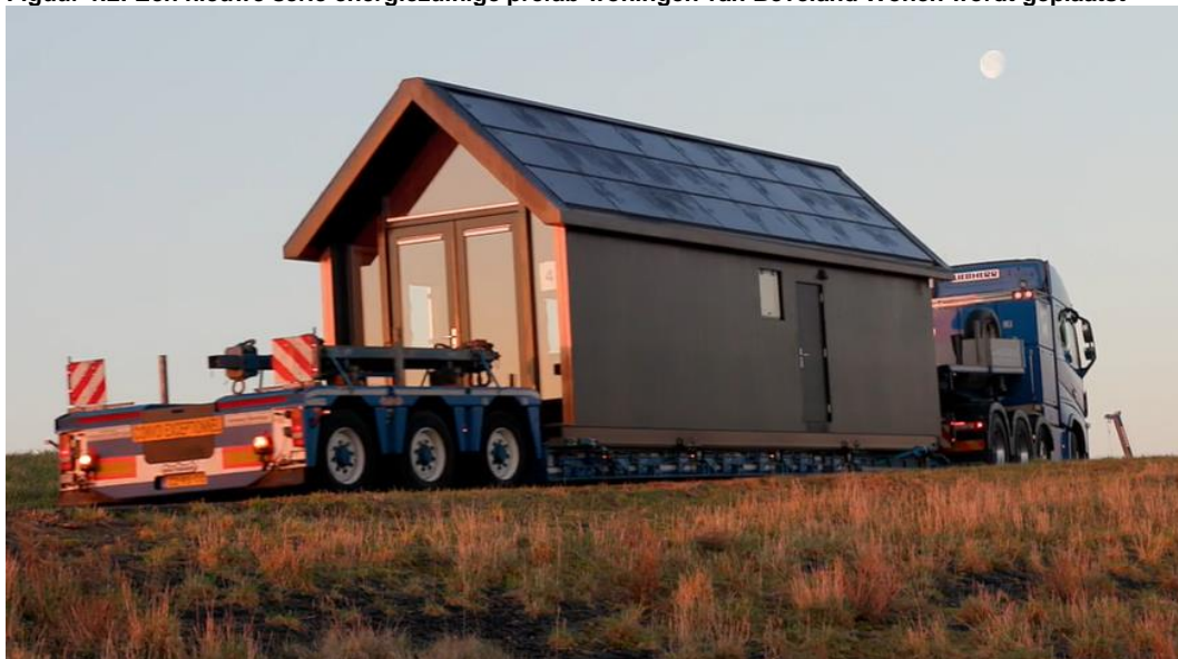
Figuur 1.2: Een nieuwe serie energiezuinige prefab-woningen van Beveland Wonen wordt geplaatst
