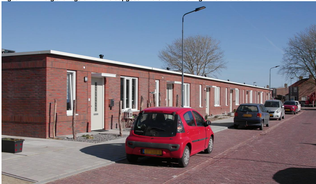
Figuur 1.1: Energiezuinige en levensloopgeschikte Curaviewoningen van Beveland Wonen
