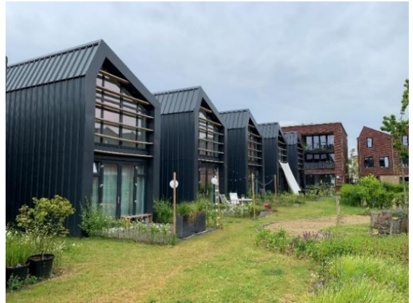
Foto van 'Area-M' met de tiny houses en de gezinswoningen.
