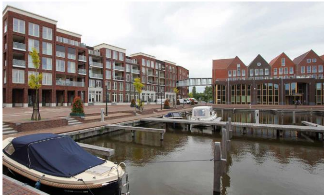
Bron: Woongroep Marenland, gezondheidscentrum en (zorg-)appartementen Overdiep, Appingedam
