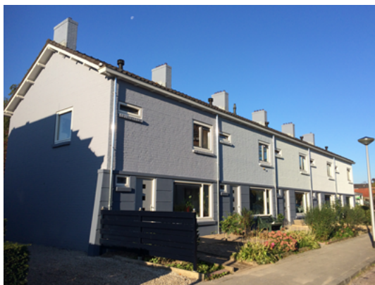
Project Overkerk voor en na renovatie
