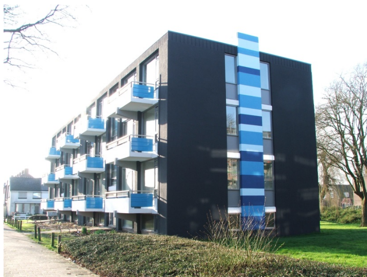
Project Hendrik voor en na renovatie
