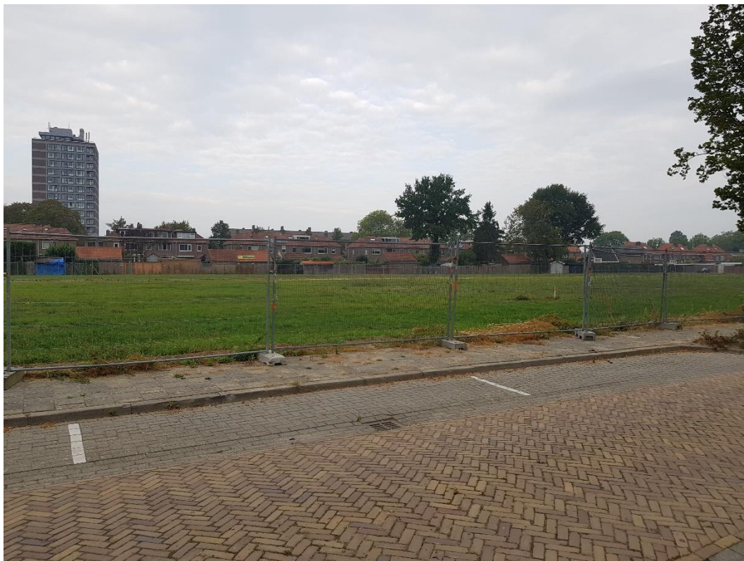
Afbeelding 1.1: Recent gesloopte buurt door Poort6 gezien vanaf de Van Zomerelaan, nu bestemd voor herontwikkeling.
