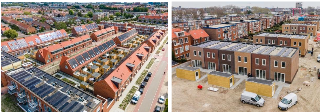
Foto 2 Luchtfoto van Ravesteynplein (links) en foto van De Hofjes (rechts)
