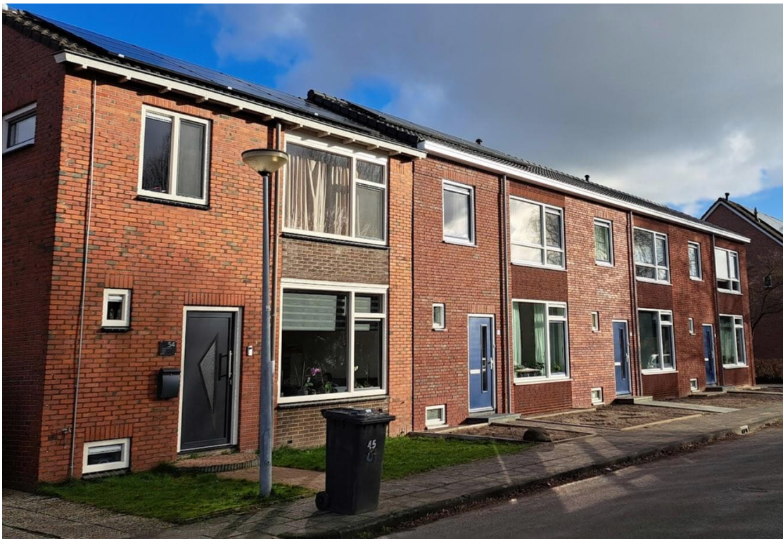
Verduurzaamde woningen Fazantweg/Patrijsweg
