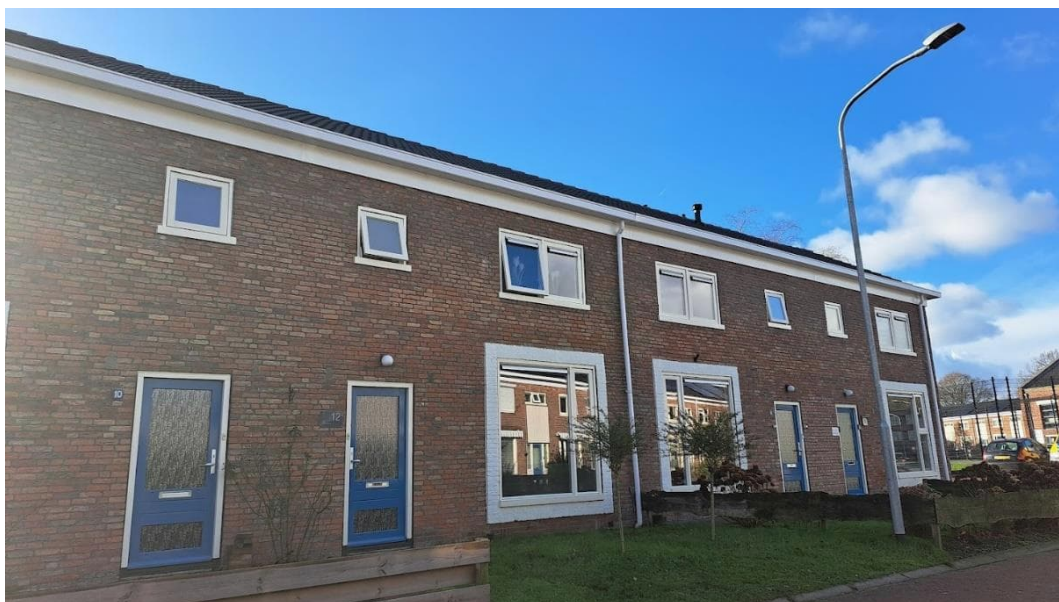
Woningen in de wijk Nieuwe Akkers na renovatie
